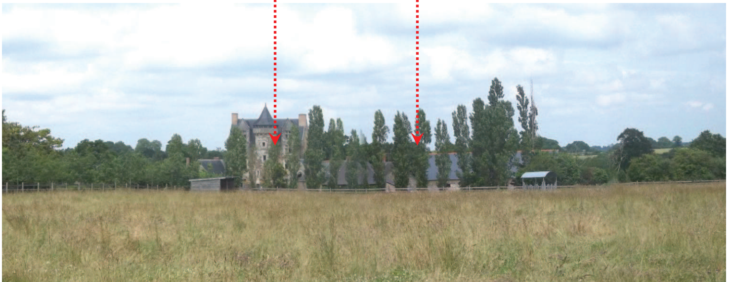
Perception depuis la RD 29- Les peupliers cachent en partie le bâtiment
